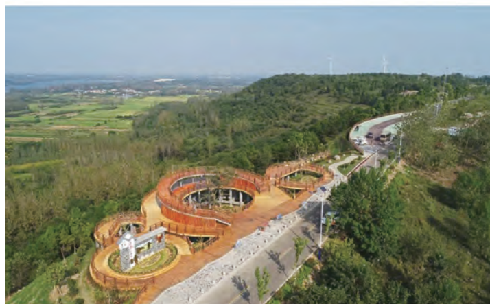
图 15 来安红岭段·半塔岭上观景台
