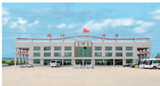
图6 同江口岸东港联检大楼
