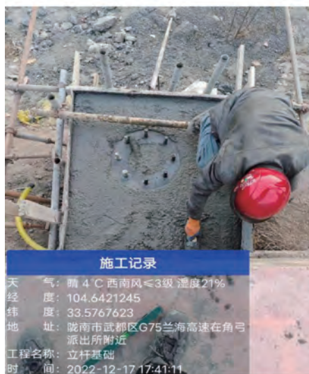
图4 工程施工记录
