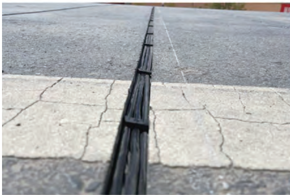
图 12 动态称重设备安装
