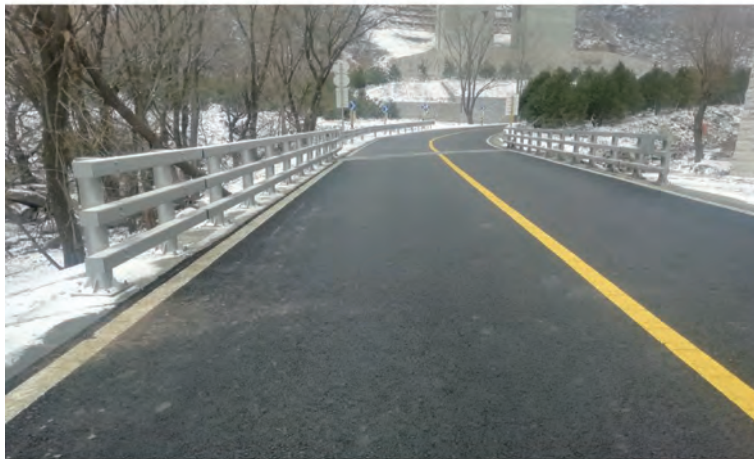
图 21 松闫路安防工程完工后
