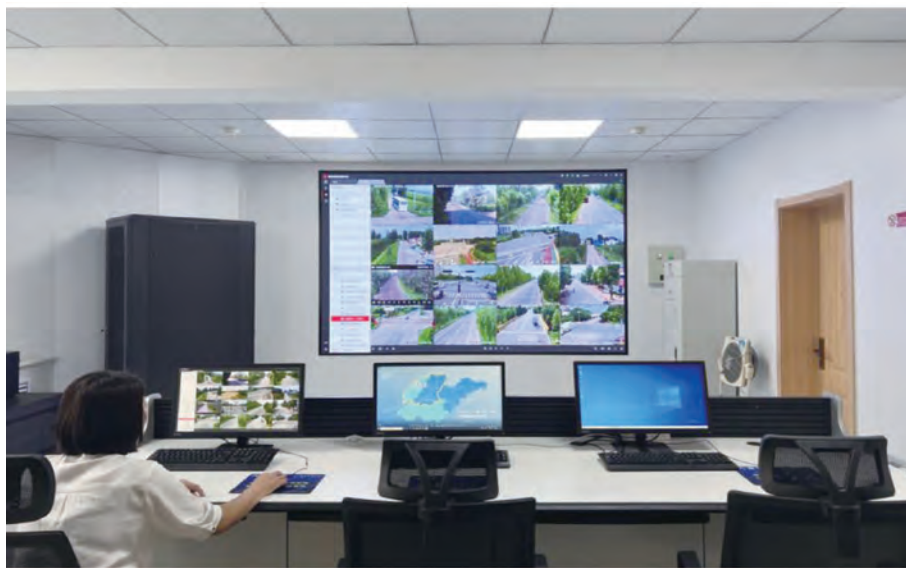
图1 齐河县农村公路信息化大厅
