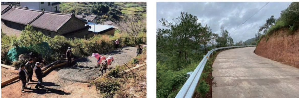
图6 正在实施和实施完成的南石坪、水资路自然村公路
