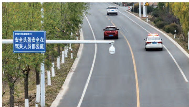
图5 道路监控系统
