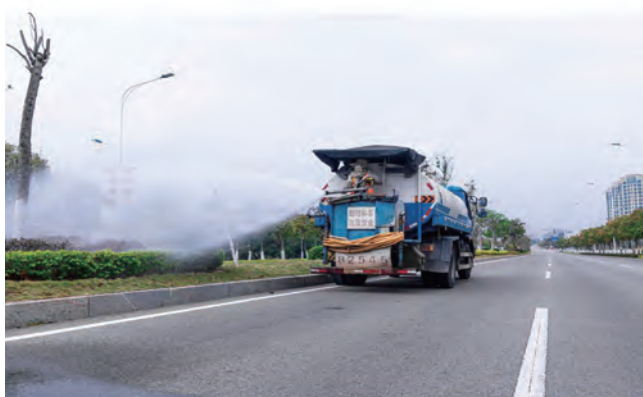
图6 道路养护作业
