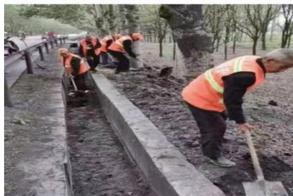
图 2 养护人员清除排水渠
