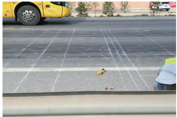
图 12 动态称重设备安装
