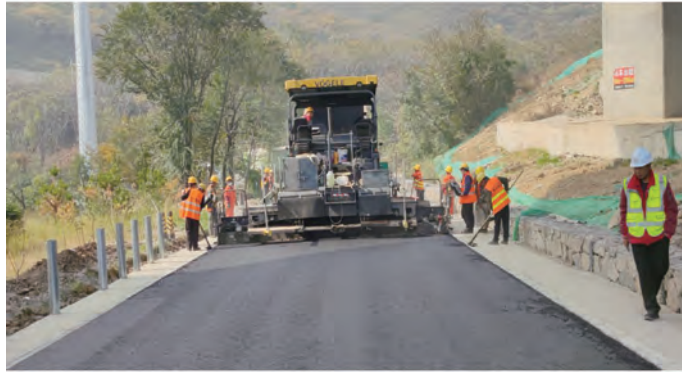
图 11 铺设 DTC 相变融冰雪材料
