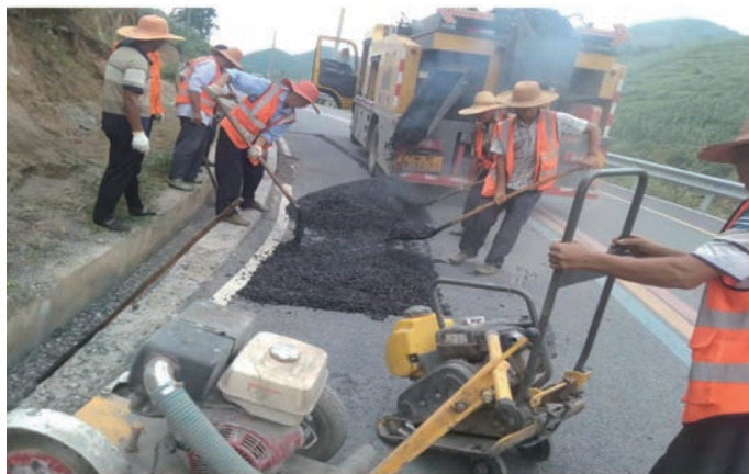
图3 县公路部门对农村公路实施病害处治
