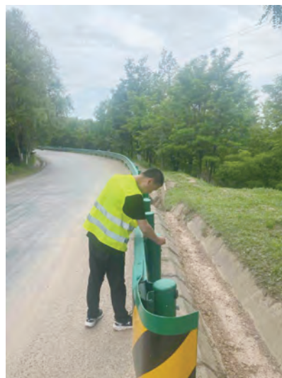
图9 安装智能传感设备
